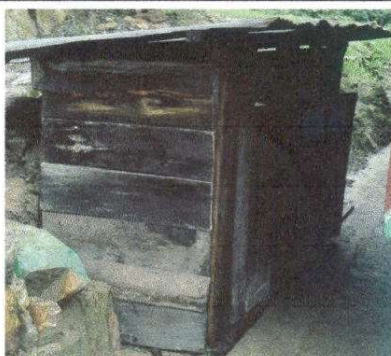
Foto 3: paredes de baños con madera, se quiere mejorar colocando muros.
